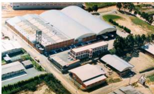
Foto 4: Vista aérea da unidade industrial de Rio Negrinho – CAHDAM Volta Grande S/A.
