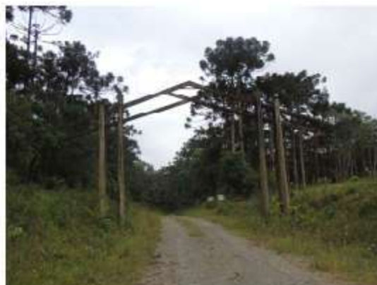
Foto 11: Portal de entrada da RPPNE Parque das Araucárias, montado em madeira de vigas de eucalipto tratado (Foto: Langa R.)
