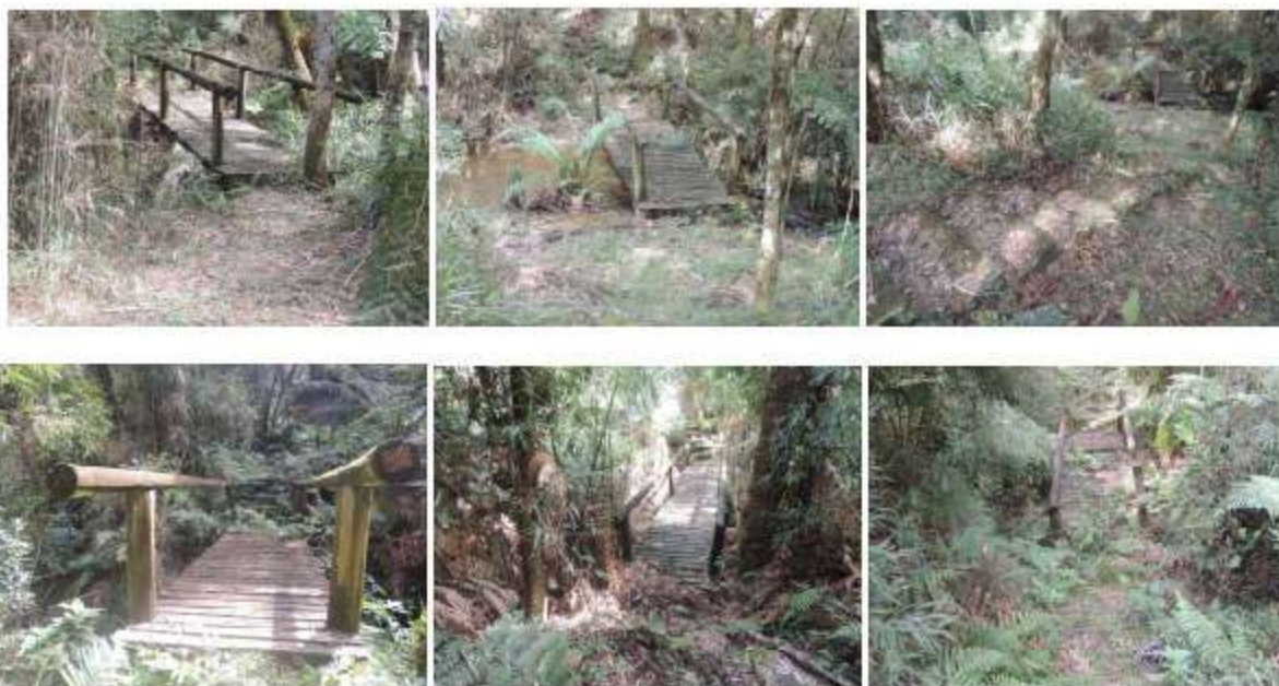
Prancha 14: Infra estruturas de pontes e escadas aplicadas na trilha do Xaxim, na RPPNE Parque das Araucárias (Foto: Langa R.)
