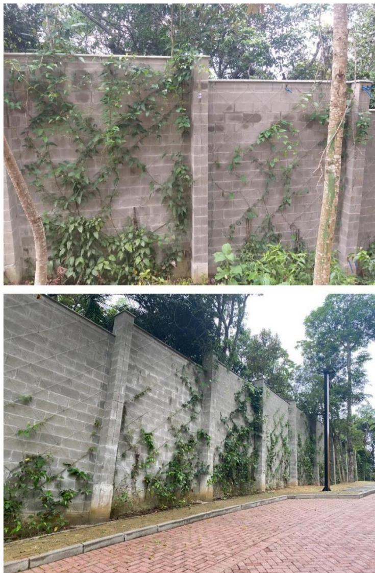
Figura 52 – Muros com fios de garrafa PET para auxiliar na fixação da vegetação no muro
