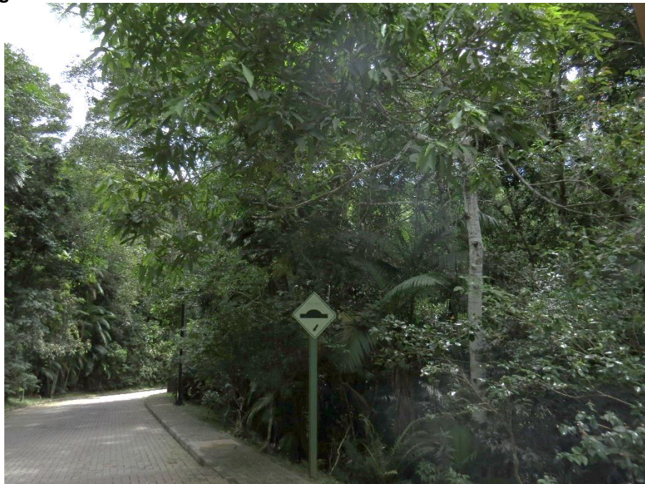
Figura 58 – Limitadores de velocidade como lombadas instalados na estrada
