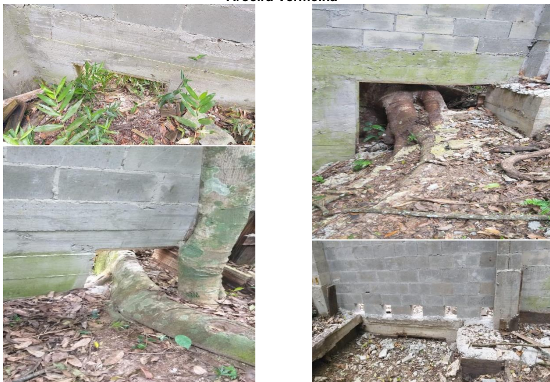
Figura 50 – Passa-fauna e espaçamento para troncos entre os muros que cercam a RPPNE Aroeira Vermelha
