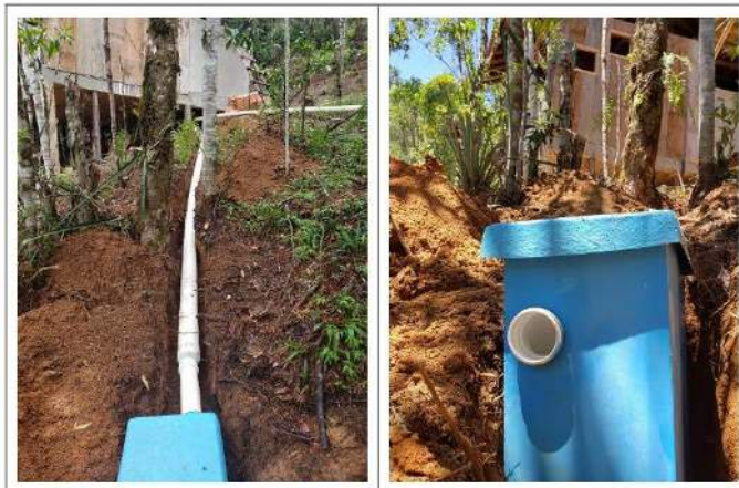
Figura 2: Tecnologia RASC sendo instalada
