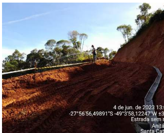
Figura 31: Instalação das canaletas para desvio da água da chuva Fonte: Amanda Chaaban
