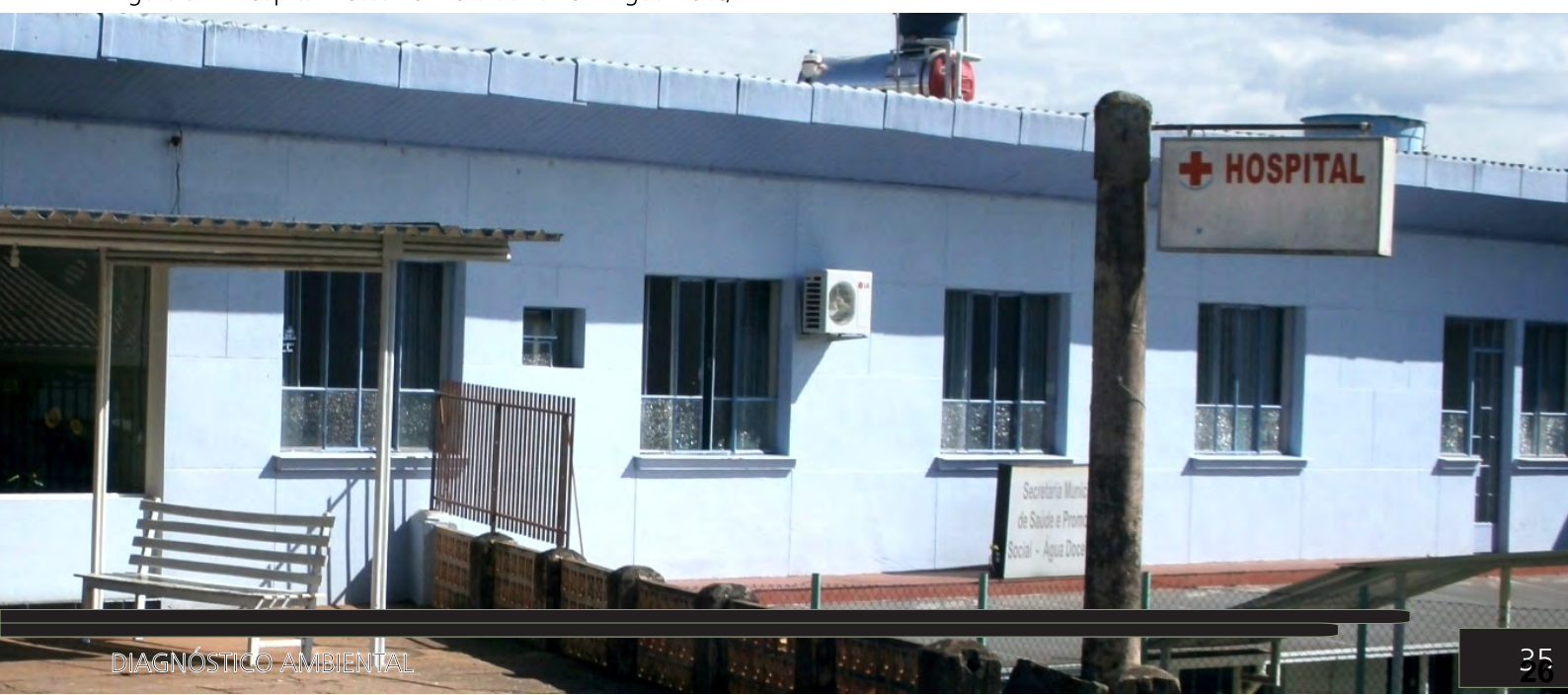
Figura 57 - Hospital Nossa Senhora da Paz em Água Doce/SC.
