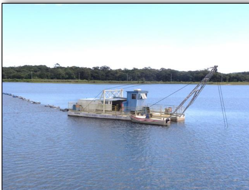
Foto 2.03. Draga em Operação na Lagoa de Extração.
