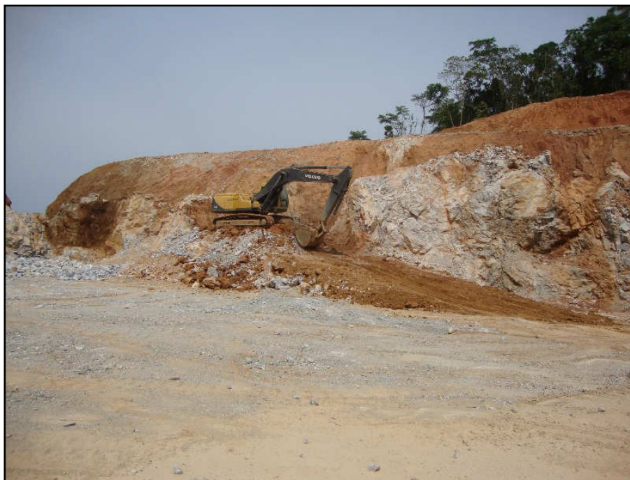
Figura 5.1 – Decapeamento de solo realizado com escavadeira.
