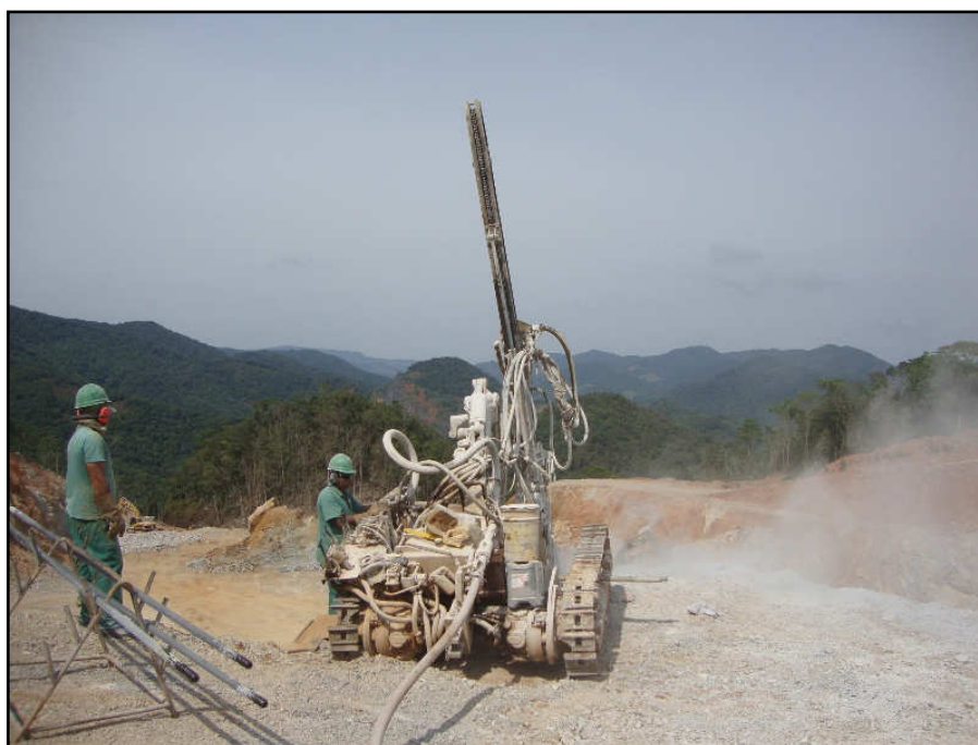
Figura 5.2 – Equipamento utilizado na perfuração da rocha para desmonte.
