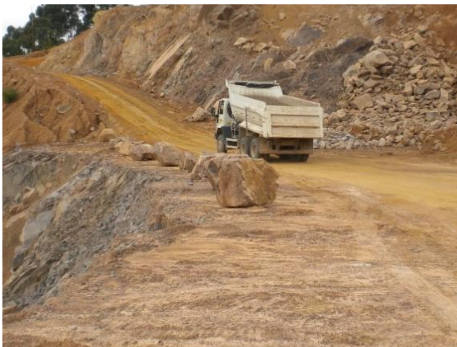
Figura 6 – Transporte de material e vista sobre unidade de beneficiamento do empreendimento.
