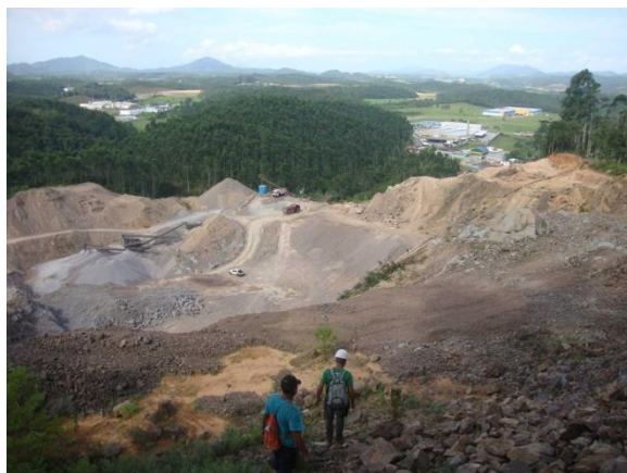
Figura 37 - Vista geral da área atualmente em operação do empreendimento.
