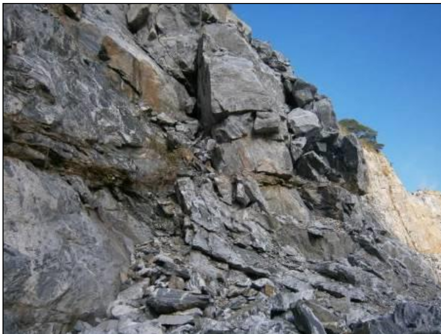
Figura 16. Gnaisses com alto grau de fraturamento presente na área de lavra.
