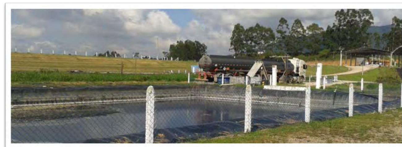
Figura 10 – Sistema de coleta e transporte de chorume para o tratamento na ETE RIOVIVO (Brusque).
