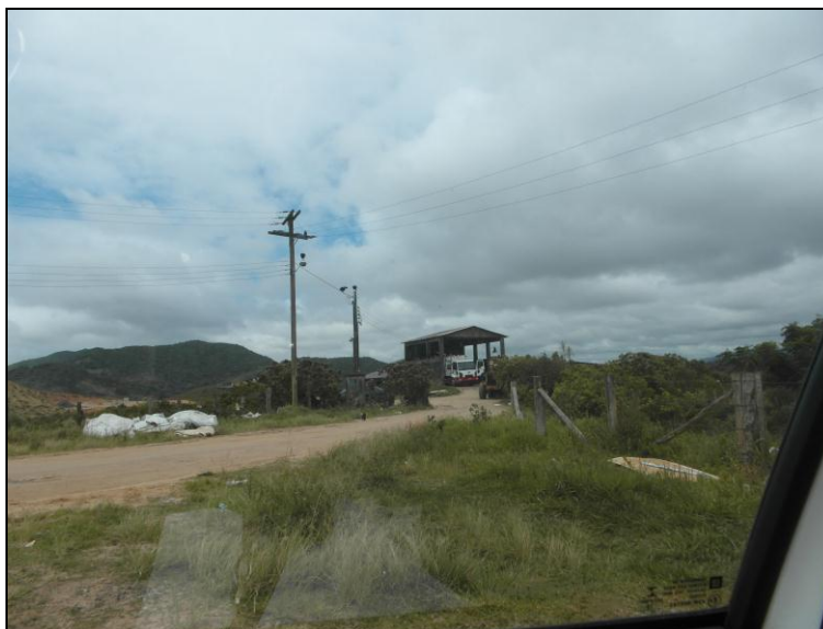
Figura 8-27 – Usina de Triagem e Compostagem de Imbituba.
