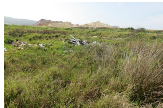
Foto 8-14 - Escombros e detritos espalhados por toda a área.
