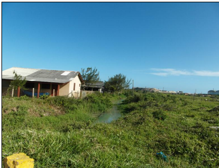
Figura 8-26 – Córrego que desagua no mar e passa atrás das moradias localizadas na ADA.
