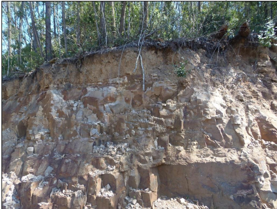
Figura 5 - Detalhe das camadas do arenito cinza esbranquiçado da Formação Rio Bonito.
