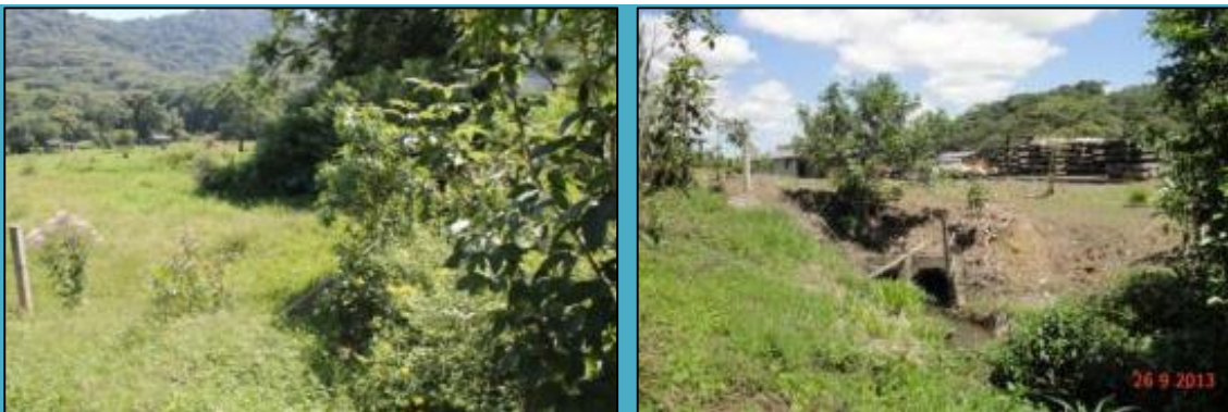
Córrego 3 a montante do Canteiro da Triunfo, a esquerda; tubulação para a passagem do córrego sob o canteiro da empresa, a direita.
