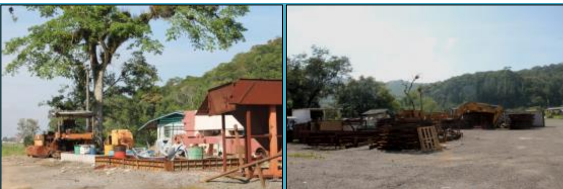
Equipamentos para manutenção e sucatas no canteiro de obras.
