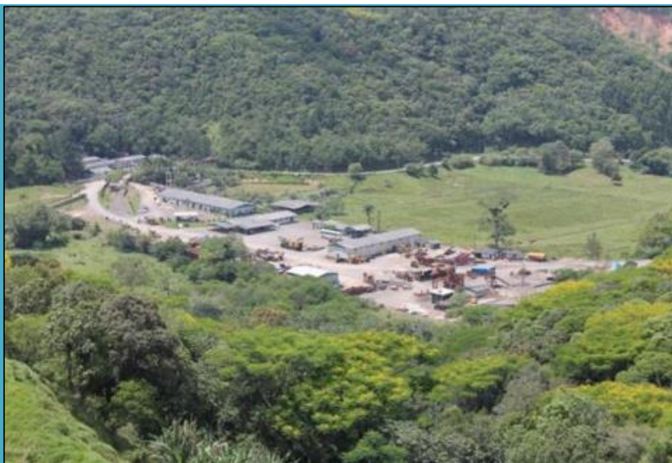
Vista do canteiro de obras da Pedreira Machados.
