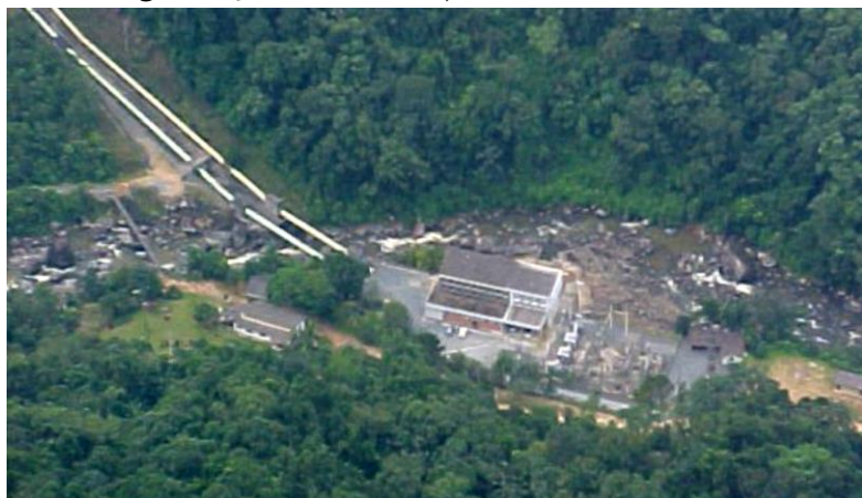
Figura 14 - Casa de força da PCH Palmeiras.
