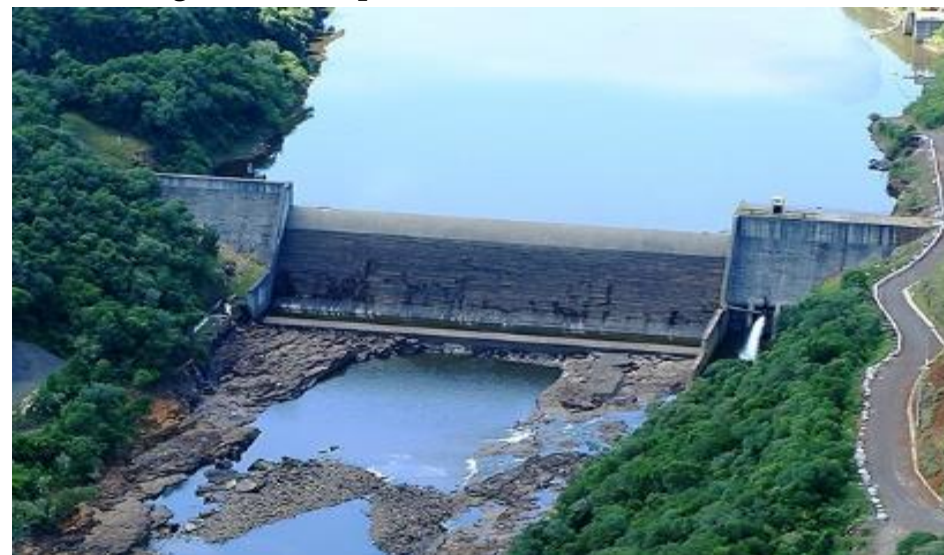
Figura 2 - Exemplo de vertedouro de soleira livre.
