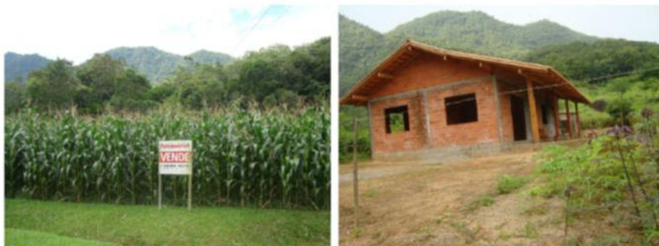
Figura 56 - Terreno a venda e casa em construção
