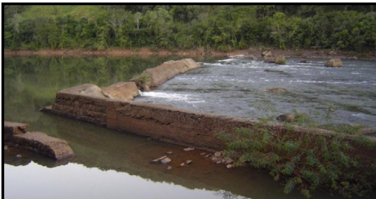
Figura 4.4: Local da barragem, vista da margem direita. Fonte: Design Head, 2012.
