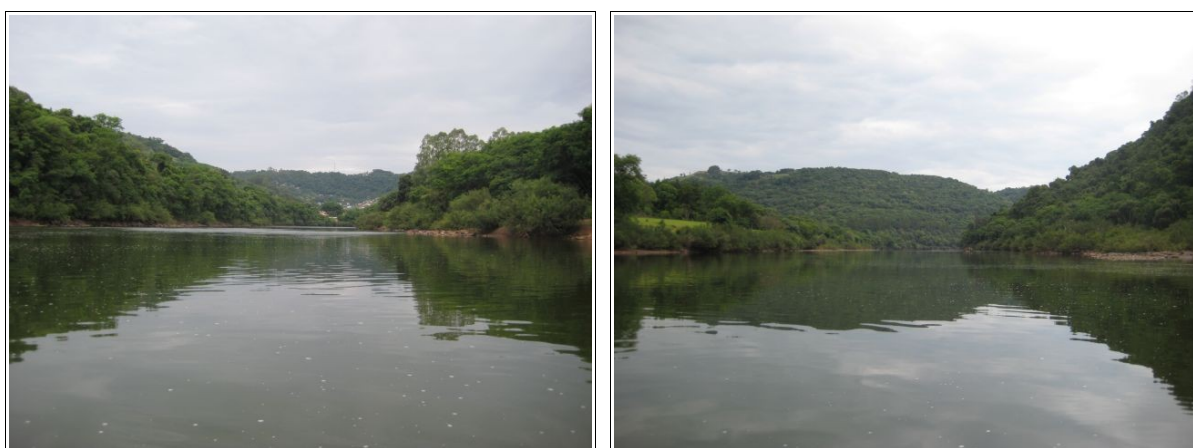
Figura 9.11 - Vista a jusante e a montante do ponto 02.
