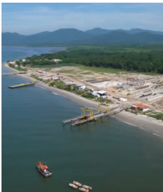
Exemplo da Estrutura Provisória de Acesso
