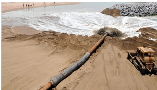
Lançamento de Material Dragado e Formação do Aterro Hidráulico
