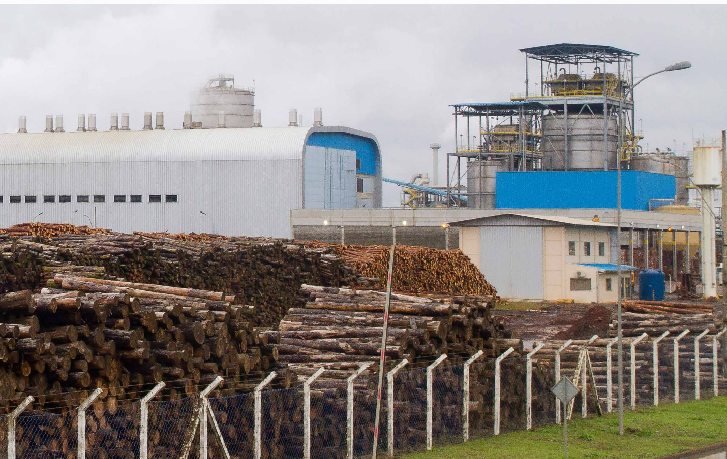
Vista do pátio de estocagem de toras, planta de aparas e parte da máquina de papel da WestRock em Três Barras
