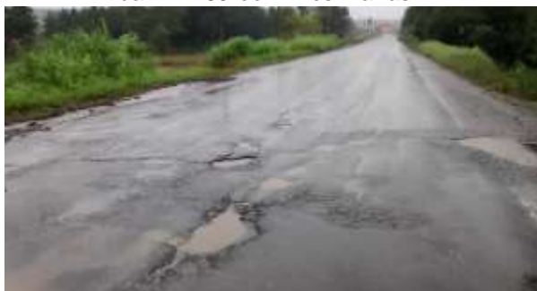
Figura 10.3-136: Aspecto das condições do pavimento e da sinalização horizontal no segmento da SC 120 – Segmento da interseção da BR 280 com Três Barras.
