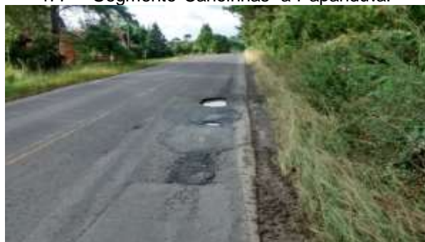
Figura 10.3-153: Aspecto das condições do pavimento e da sinalização horizontal no segmento da SC 477 - Segmento Canoinhas a Papanduva.
