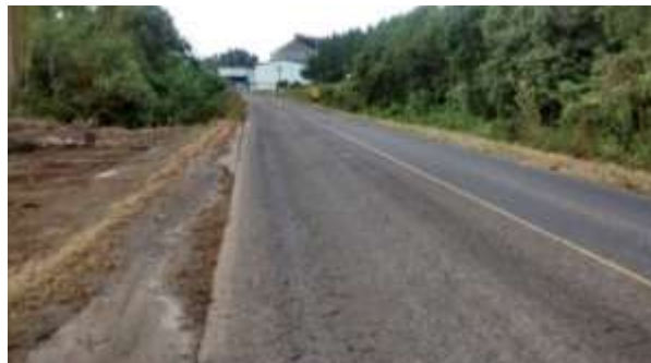
Figura 10.3-151: Aspecto do raio de curva e ausência de acostamento em segmento da SC 477 - Segmento Canoinhas a Papanduva.
