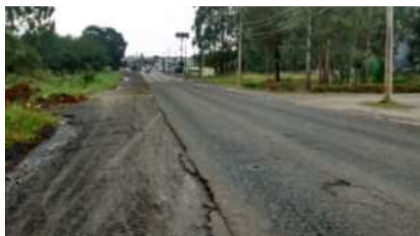
Figura 10.3-149: Aspecto das condições do pavimento e da sinalização horizontal no segmento da SC 477 – Segmento Canoinhas a Papanduva.
