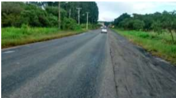
Figura 10.3-150: Aspecto de acostamento sem pavimentação em segmento da SC 477 - Segmento Canoinhas a Papanduva.
