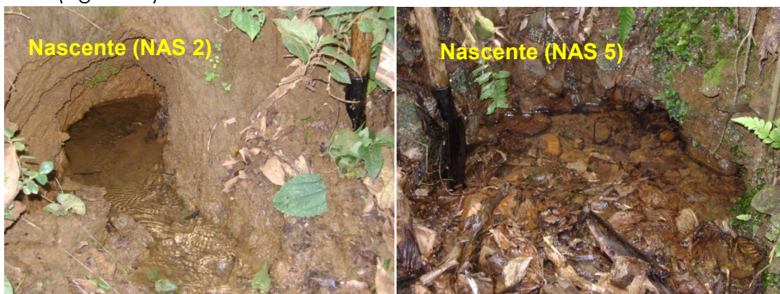
Figura 17 – Detalhe das nascentes na camada de colúvio com tipologia de conduto.
