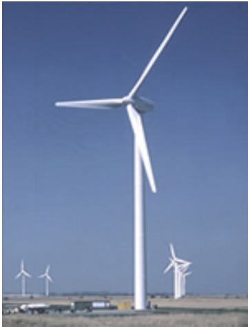
Figura 6 – Aerogerador de Eixo Horizontal Eixo Vertical Fonte: CRESESB (2011)
