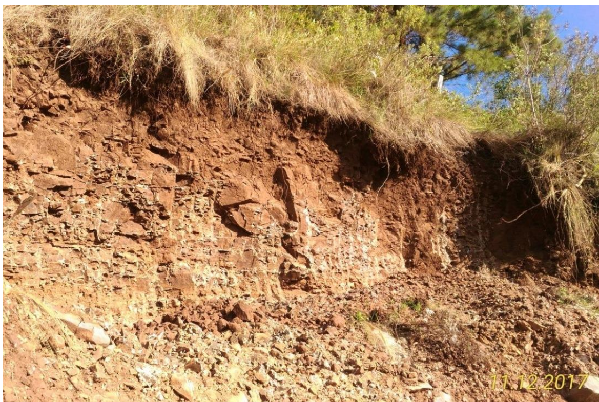
Aspecto geral de Talude de Corte de Neossolo Litólico.
