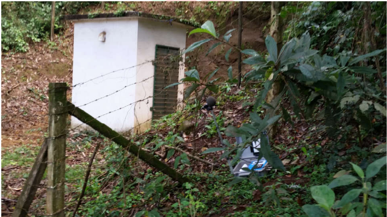
Foto 04: Local onde foi instalado o sismógrafo, sendo este, Paio de explosivos, em uma distância de 596,45 metros do local do desmonte.
