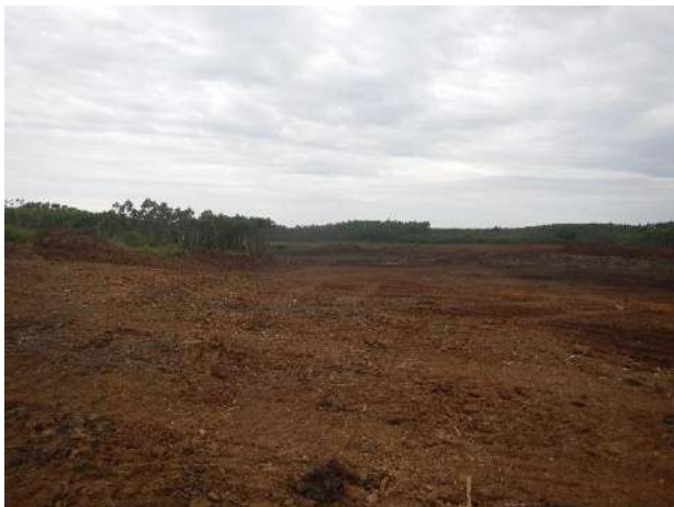
Foto 05: Área de construção da subestação Siderópolis 2, com um solo marrom argiloso.
