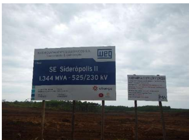
Foto 01: Área de construção da subestação Siderópolis 2.
