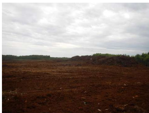
Foto 02: Área de construção da subestação Siderópolis 2, com um solo marrom argiloso.
