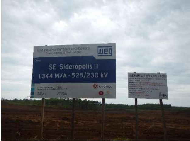
Foto 01: Área de construção da subestação Siderópolis 2.
