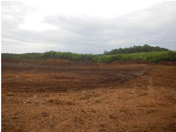
Foto 03: Área de construção da subestação Siderópolis 2, com um solo marrom argiloso.
