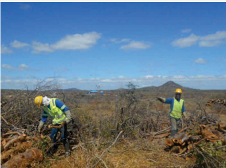
Uso de EPIs (capacete, protetor auricular, touca árabe, botas, luvas, perneira, óculos e colete) pelos colaboradores envolvidos na atividade de supressão vegetal.
