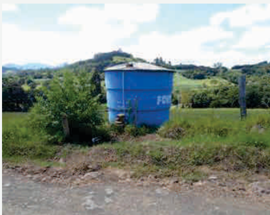
Caixa d'água da localidade de Palmeiras do Sertão, em Santo Antônio da Patrulha/RS.
