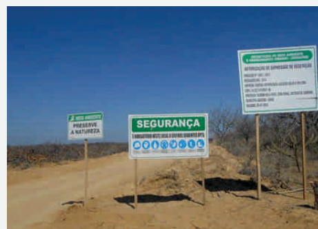
Exemplo de medida do PAC: controle de sinalização de obra.
