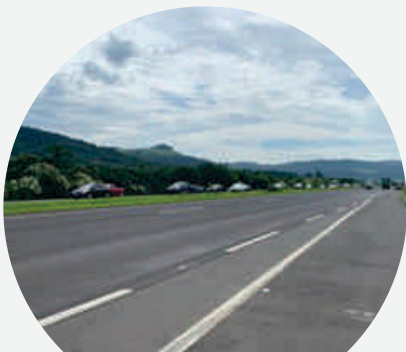
Local de travessia da LT sobre a Rodovia Federal BR-290.
