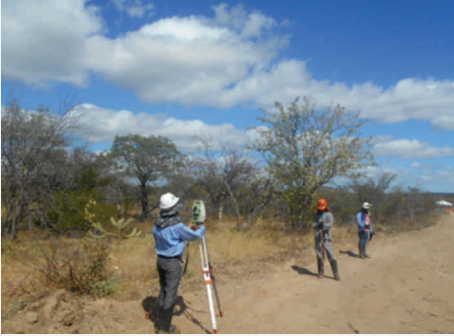
Exemplo de medida de controle de supressão - equipe de topografia demarcando o perímetro das áreas a serem suprimidas.
