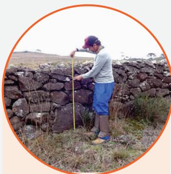
Medição do muro de pedra.
