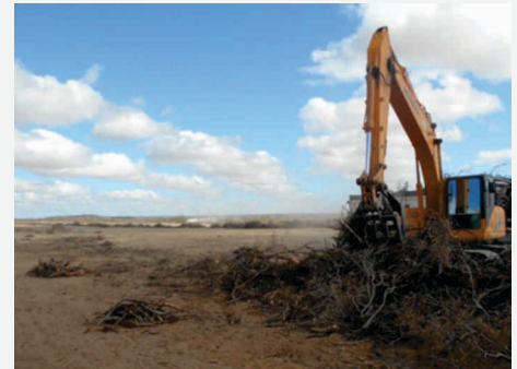
Controle de supressão - máquina realizando disposição e manejo do Topsoil e galhada fina.
