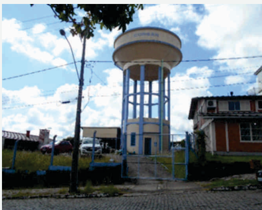
Caixa de Água na sede de São Francisco de Paula/RS.
