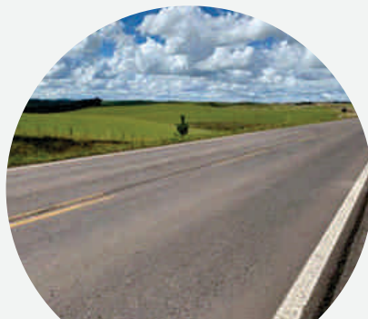
Local de travessia da LT sobre a rodovia RS-020.
