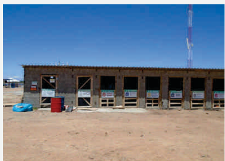
Exemplo de medida do PAC: gestão de resíduos sólidos - central de resíduos, com baias para acondicionamento provisório de resíduos sólidos e químicos separadamente, contendo placas de identificação por tipo de resíduo.
