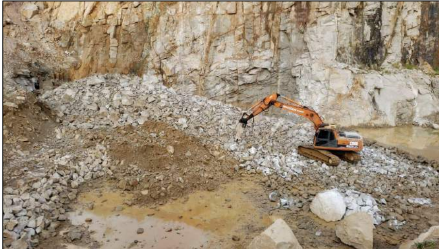
Figura 3-8: Escavadeira com rompedor realizando desmonte secundário.
