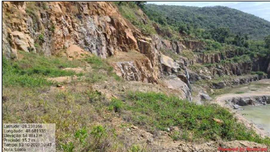
Figura 6-2 - Granito ocorrente na pedreira atual, incluindo a base da lava.
