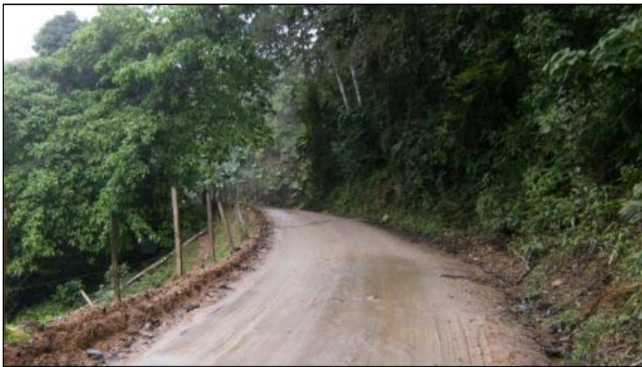
Figura 5-33: Aspecto da estrada municipal, em trecho não pavimentado, na comunidade de Sete de Janeiro, que constitui o principal arruamento do local.
