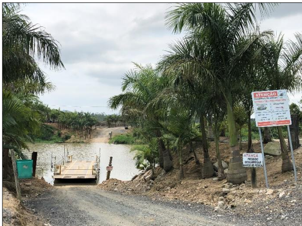
Figura 5.3: Estrutura de travessia sobre o Rio Itapocu, sentido São João do Itaperiú-Araquari.
