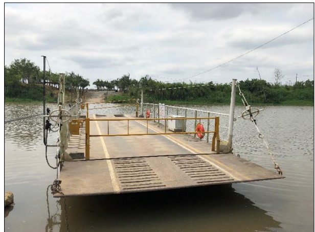
Figura 5.4: Balsa utilizada para a travessia do rio Itapocu.
