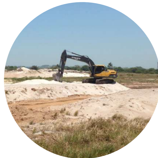
Preparação da área de lavra com a remoção do solo orgânico e estéril por escavadeira hidráulica e abertura de acessos para o início da lavra por escavadeira hidráulica.
