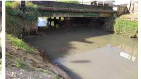
Ponte com muro de pedra, no rio Itaum-Açu, na rua Florianópolis
