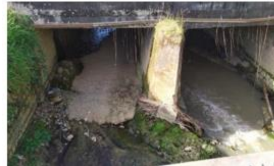
Galeria com muro de pedra, no rio Itaum-Açu, na rua Monsenhor Gercino
