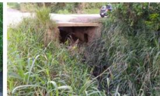
Tubo de concreto no rio Itaum-Açu, na rua Carlos Emilio Alexandre Schwartz
