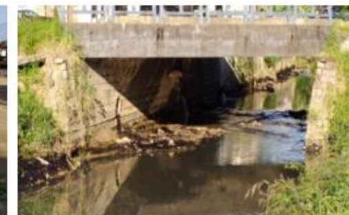
Detalhe sob a ponte no rio Itaum-Mirim, na rua Fátima
