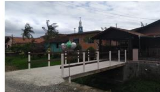
Fonte: WALM, 2020 Residência na R. Servidão Petronilha da Silva, 4121 (identificação 13-11-30-29-5713)
