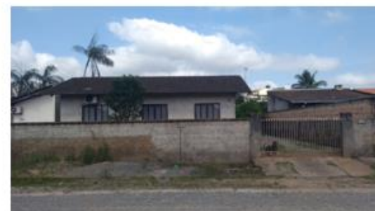
Fonte: WALM, 2020 Edificação na R. João da Luz Carvalho, 180 (identificação 13-10-5-59-1885)
