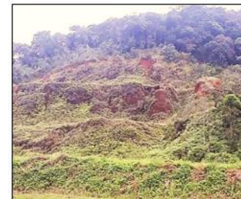
Escorregamentos em corte antigo de talude (ponto 5)
