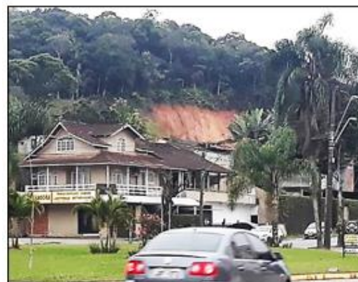
Escorregamento em corte recente de talude (ponto 4)
