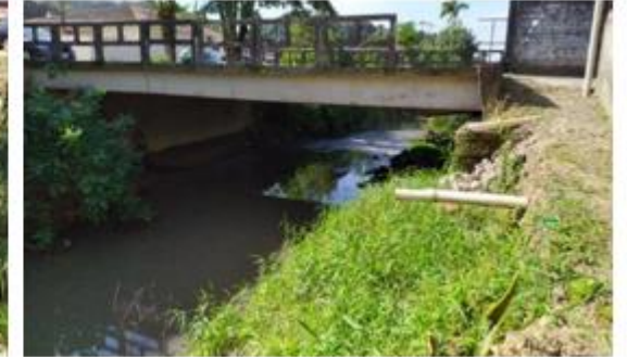
Ponte com muro de pedra, no rio Itaum-Açu, na rua Bélgica
