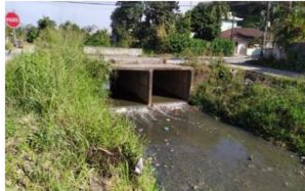
Galerias pré moldadas no rio Itaum-Açu, na rua das Telefonistas
