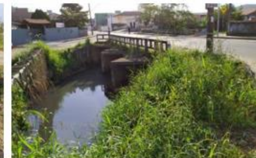
Ponte com muro de pedra, no rio Itaum-Mirim, na rua Suburbana
