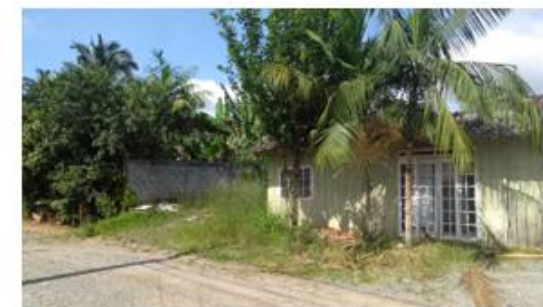
Fonte: WALM, 2020 Edificação sujeita à desapropriação na R. João da Luz Carvalho (identificação 13- 10-5-59-1876)
