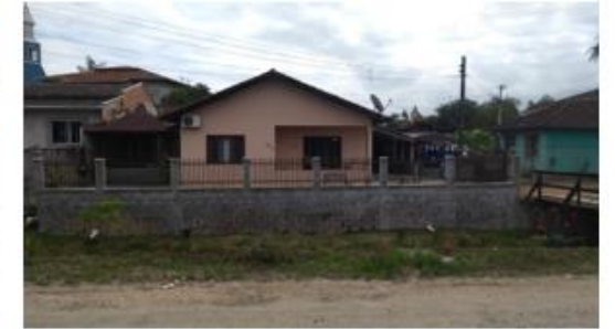
Fonte: WALM, 2020 Residência na R. Servidão Petronilha da Silva (identificação 13-11-30-29-5731)
