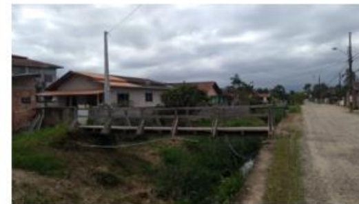
Fonte: WALM, 2020 Ponte de madeira construída para acesso à residências na R. Servidão Petronilha da Silva
