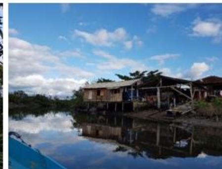
APP de Manguezal existente na AID, com ocupação antrópica (UTM 22J 718190.28 m E; 7087663.41 m S)
