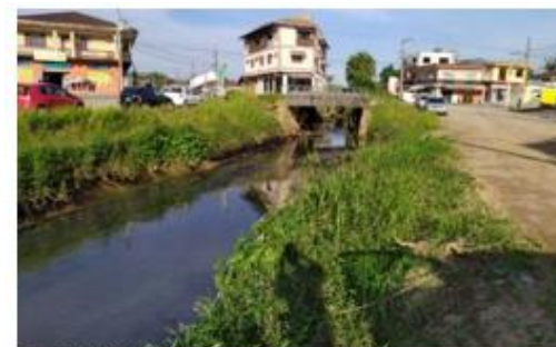
Ponte com muro de pedras no rio Itaum-Mirim, na rua Fátima
