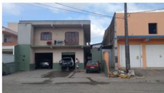
Fonte: WALM, 2020 Edificação sujeita à desapropriação na R. João da Luz Carvalho, 48 (identificação 13-10-5-59-1786)
