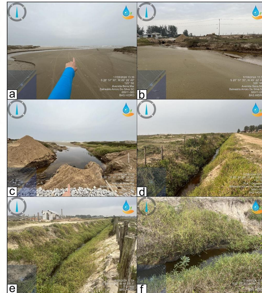
Figura 31: (a) Visada para o desague do "valão" na praia da meta. Notar a sinuosidade (meandros) confeccionados pela água naturalmente em uma região plana (oposto do canal inciso escavado no interior do terreno). (b) Ao fundo tubulação que escoam as águas do "Valão" para a praia. (c) Visada da jusante do "Valão" em a partir da Av. Beira Mar. (d) e (e) Canal retilíneo e profundo no interior da área de estudo. (f) Detalhe para uma lente de turfa próxima à lâmina d'água.
