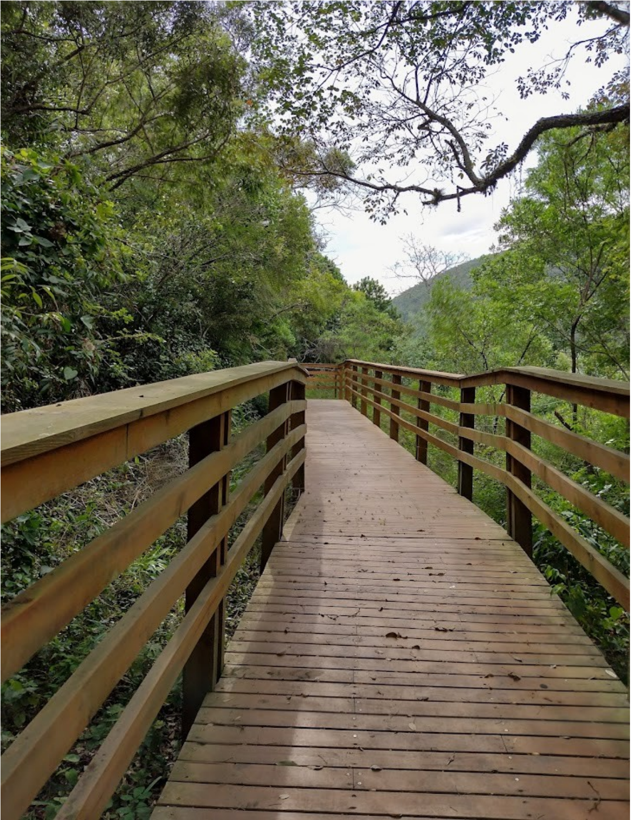
Figura 10 - Estrutura de madeira da trilha - tipo deck
