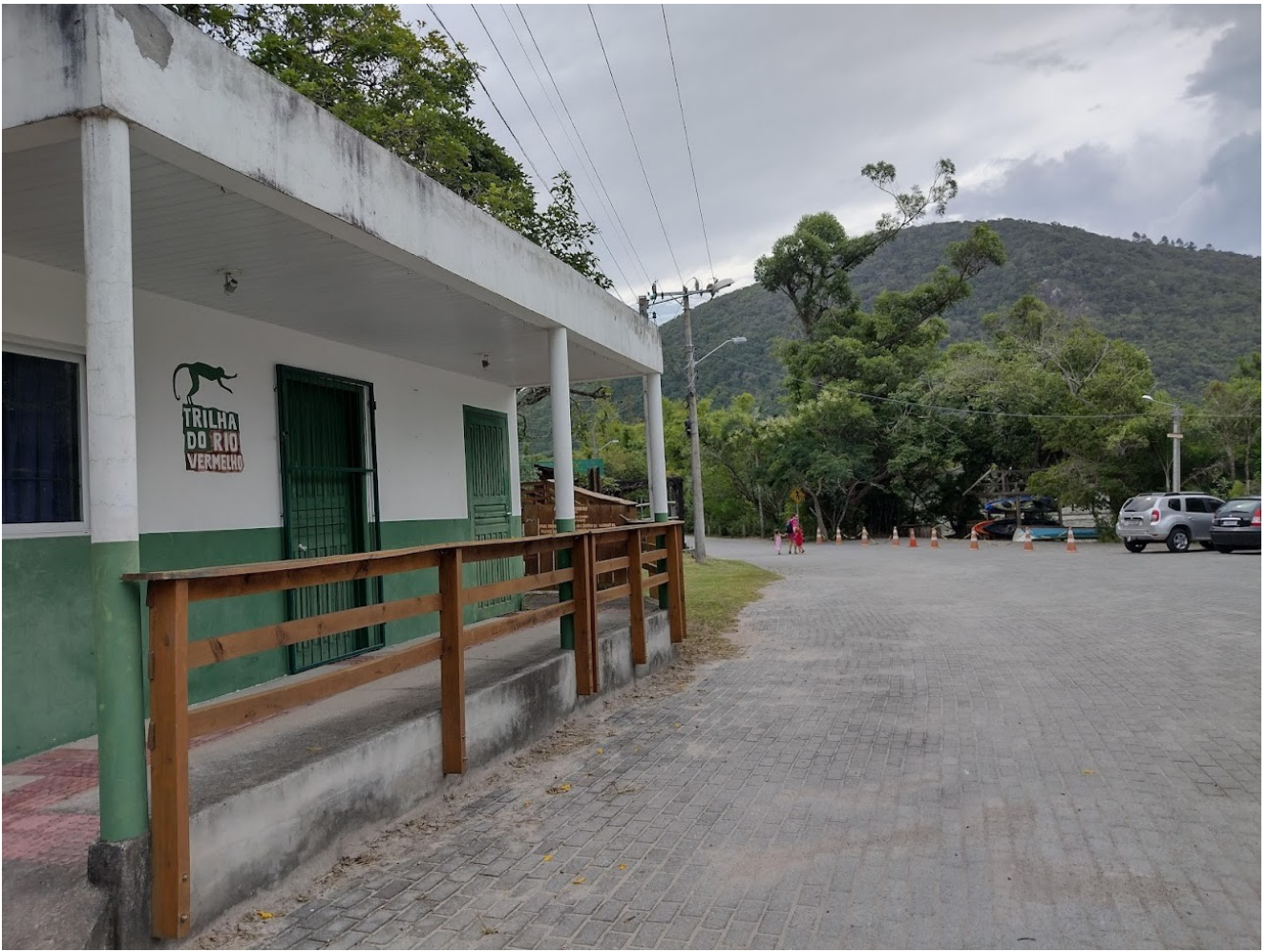
Figura 8 - Estrutura de Alvenaria na entrada do estacionamento
