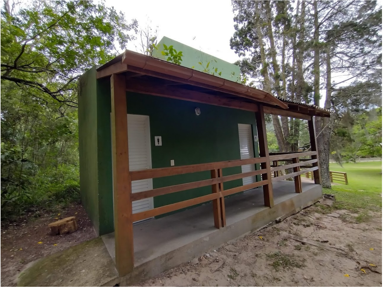
Figura 13 - Banheiros ao final da trilha
