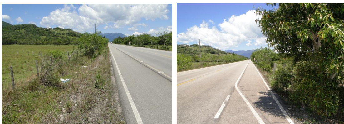
Vista da Rodovia Baldicero Filomeno
