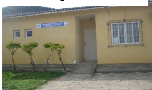
Unidade Básica de Saúde Passagem da Barra
