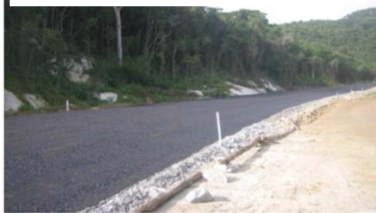
Obras de pavimentação da SC-100 nas imediações da AID.
