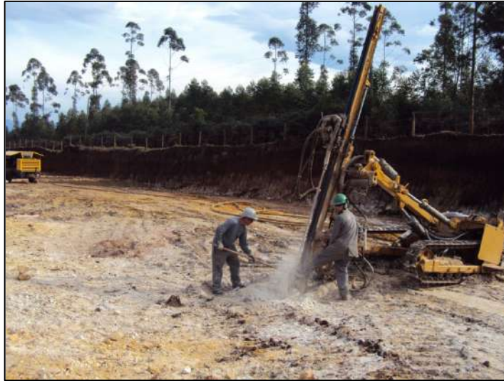
Figura 4.3 – Perfuração do pacote de arenitos de cobertura para desmonte com utilização de explosivos.
