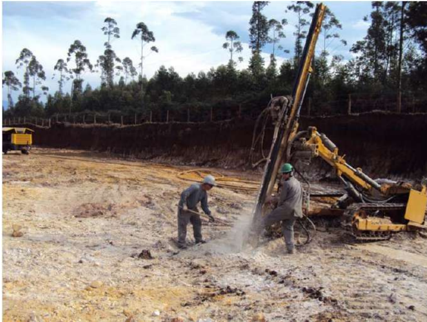
Figura 3.4 - Perfuração do pacote de arenitos de cobertura para desmonte com utilização de explosivos. Fonte: do autor
