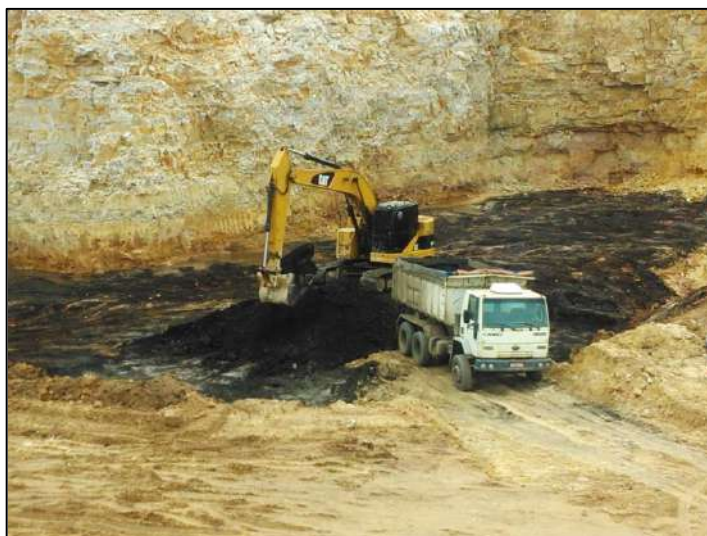
Figura 4.5 – Carregamento da camada de carvão em caminhões basculantes. Fonte: do autor
