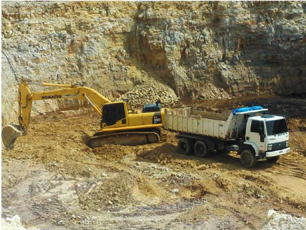
Figura 3.5 - Carregamento do material resultante do desmorte do banco de arenitos com uso de explosivos.
