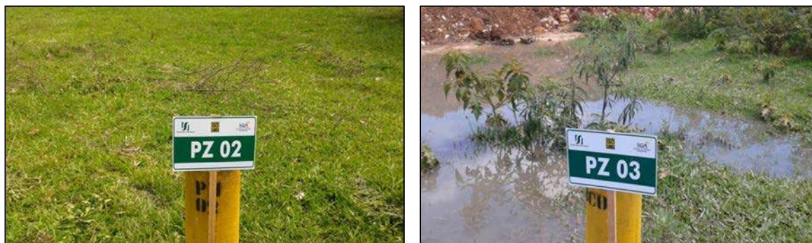
Figura 8.2 – Placas de identificação implantadas nos poços de monitoramento (piezômetros) na Mina Frente F Fonte: do autor.
