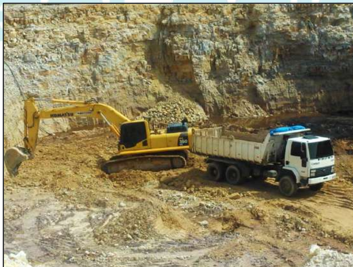
Figura 4.4 – Carregamento do material resultante do desmonte do banco de arenitos com uso de explosivos.
