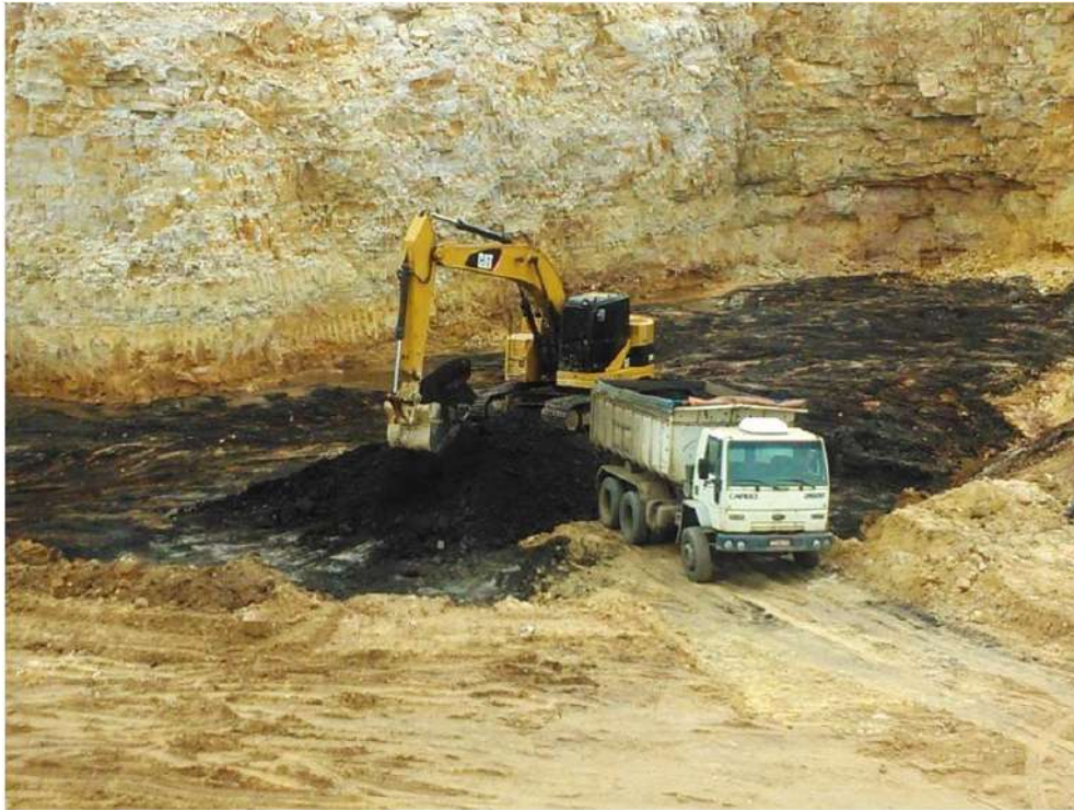
Figura 3.6 - Desmonte mecânico e carregamento da camada de carvão em caminhões basculantes. Fonte: do autor
