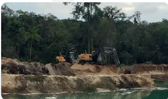
Retroescavadeira atuante como fonte de ruído
