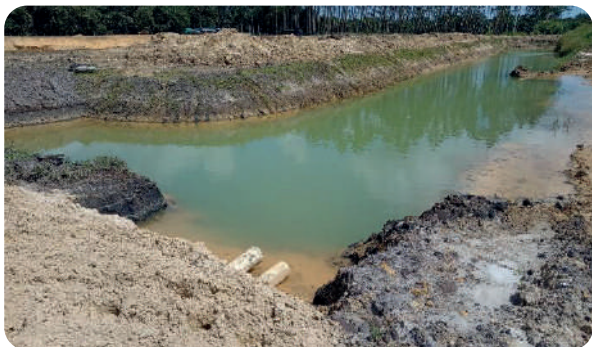
Bacia de decantação do material extraído
