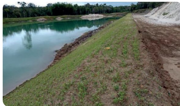
Detalhes da cava atualmente instalada com taludes recém revestidos com hidrossemeadura
